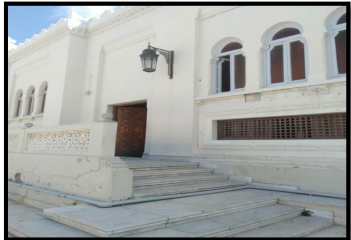
لوحة (٩) الجزء الايمن بالواجهة الشمالية الغربية لمسجد المواساة (تصوير الباحثة)
