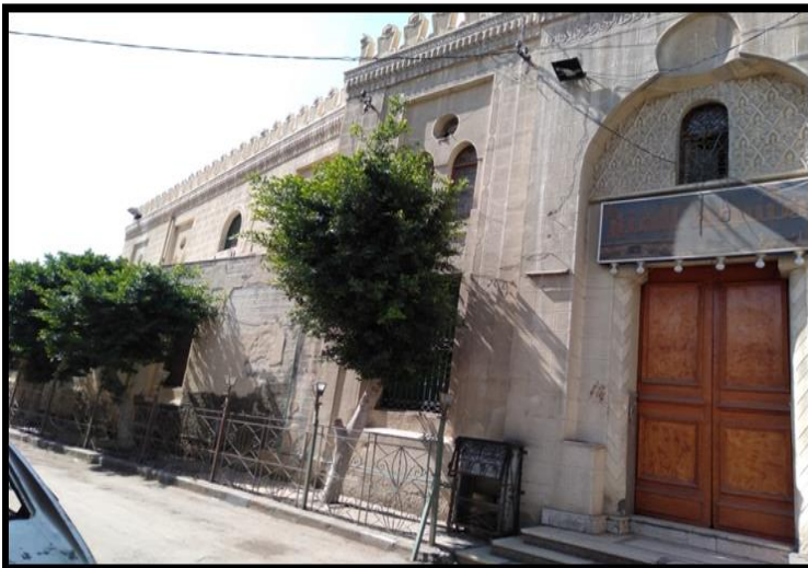
لوحة (٣) الجانب الشرقي من الواجهة الجنوبية الشرقية لمسجد سيدي المنير (تصوير الباحثة)
